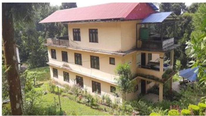
कार्यालयको निर्मित छत तथा वरण्डामा ट्रस्ट लगाउने बाकी काम सम्पन्न
