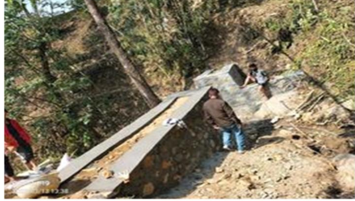
फार्म क्षेत्रमा हिड्डुल तथा मिनिटिलर संचालनकालागी कल्भर्ट निर्माण
